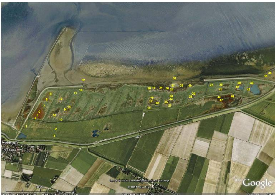
Foto 2.1 Overzicht Peazemerlannen met ligging van de 48 meetpunten. (Foto: Google Earth)
