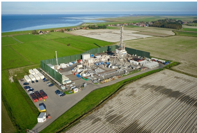
Figuur 5: Luchtfoto van de gaswinlocatie moddergat tijdens een boring.
