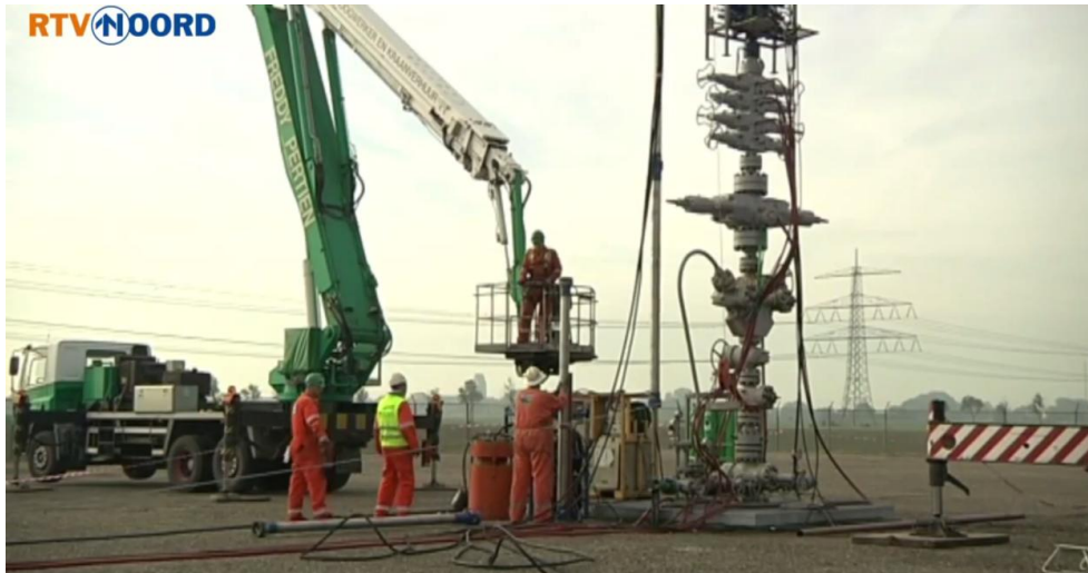
Figuur 3.8 Installatie van de string tijdelijke diepe gefoons in put Stedum-1. .
